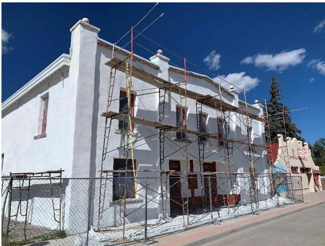
La Sociedad Protección Mutua de Trabajadores Unidos, Conejos County
